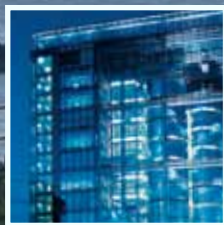
Technické vybavení budov
